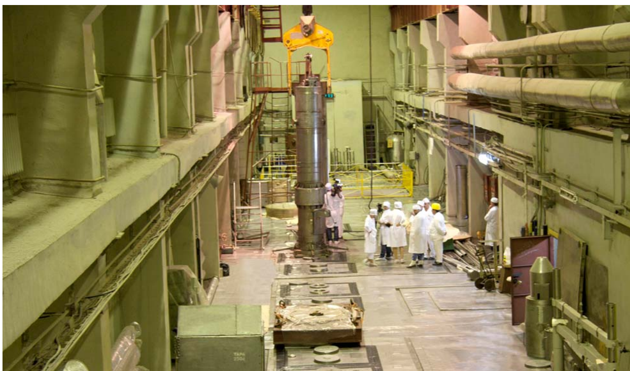
Рис. 3.25. Общий вид транспортного зала
