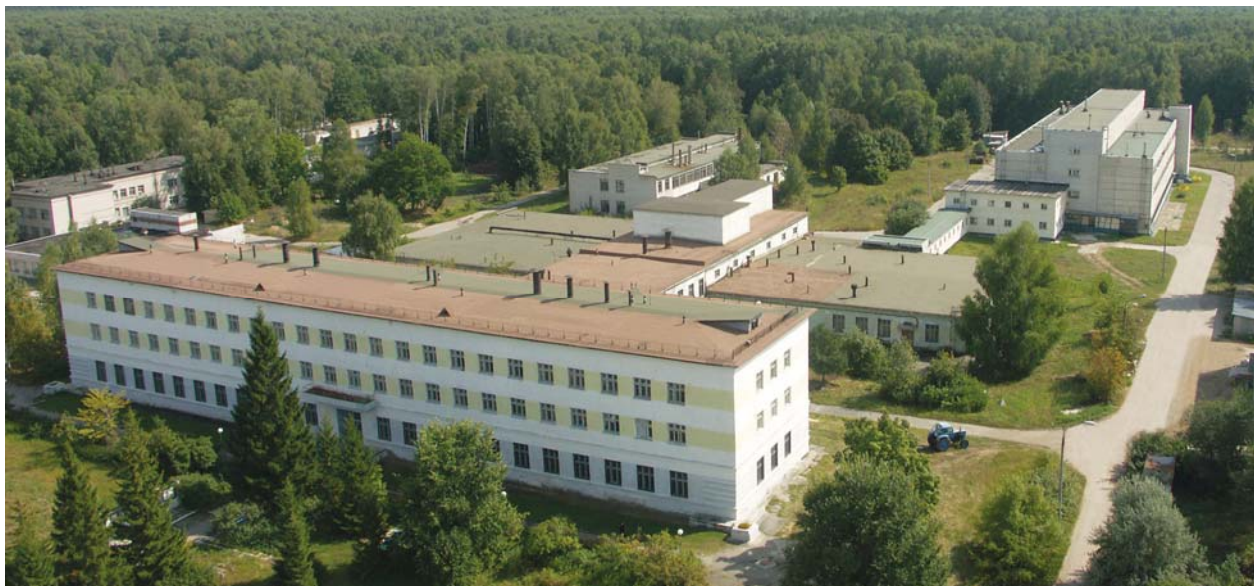
Рис. 3.24. Общий вид здания отделения реакторного материаловедения
