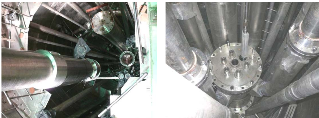
Установка корпуса реактора
