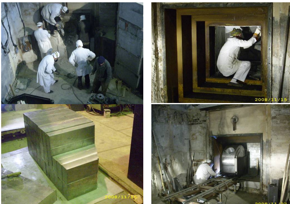
Рис. 6. Работы по демонтажу тепловой колонны и монтажу нового оборудования.
