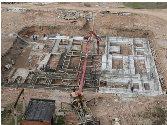
Состояние зд.116 на май 2008 г.
