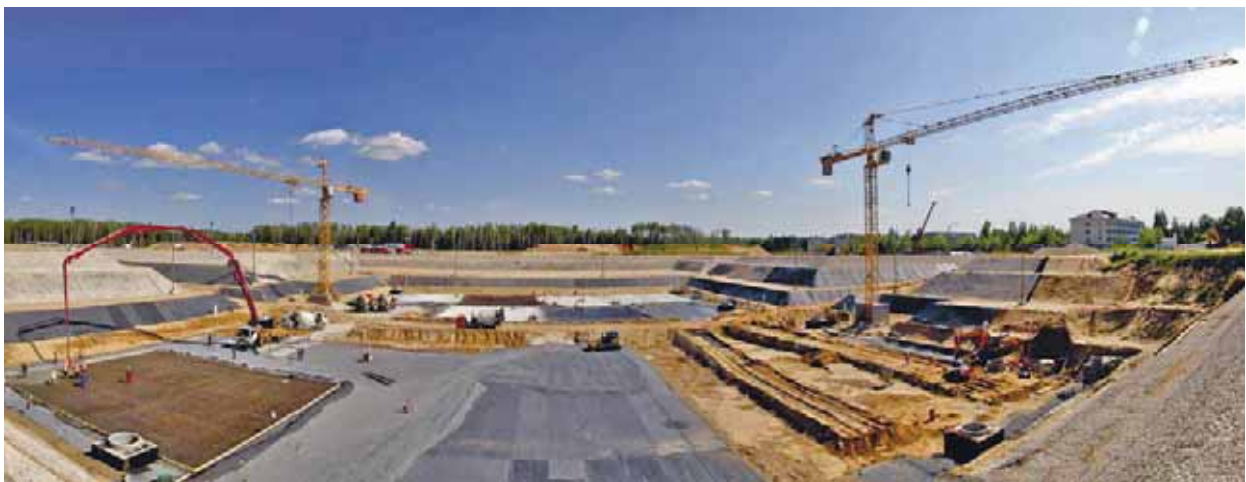
Fig. 4.9. MBIR construction site
